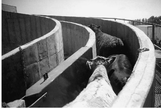
جدارهای بتونی منحنی برای احشام در کشتارگاه
